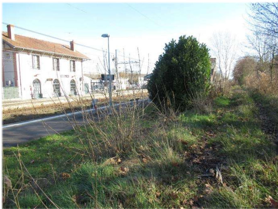
Portion plus dégagée à hauteur de la gare de Castelnau-d'Estrétefonds
