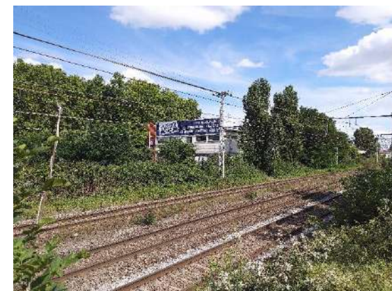
« Pont de Rupé »
