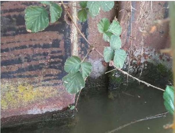
Palplanches en métal
