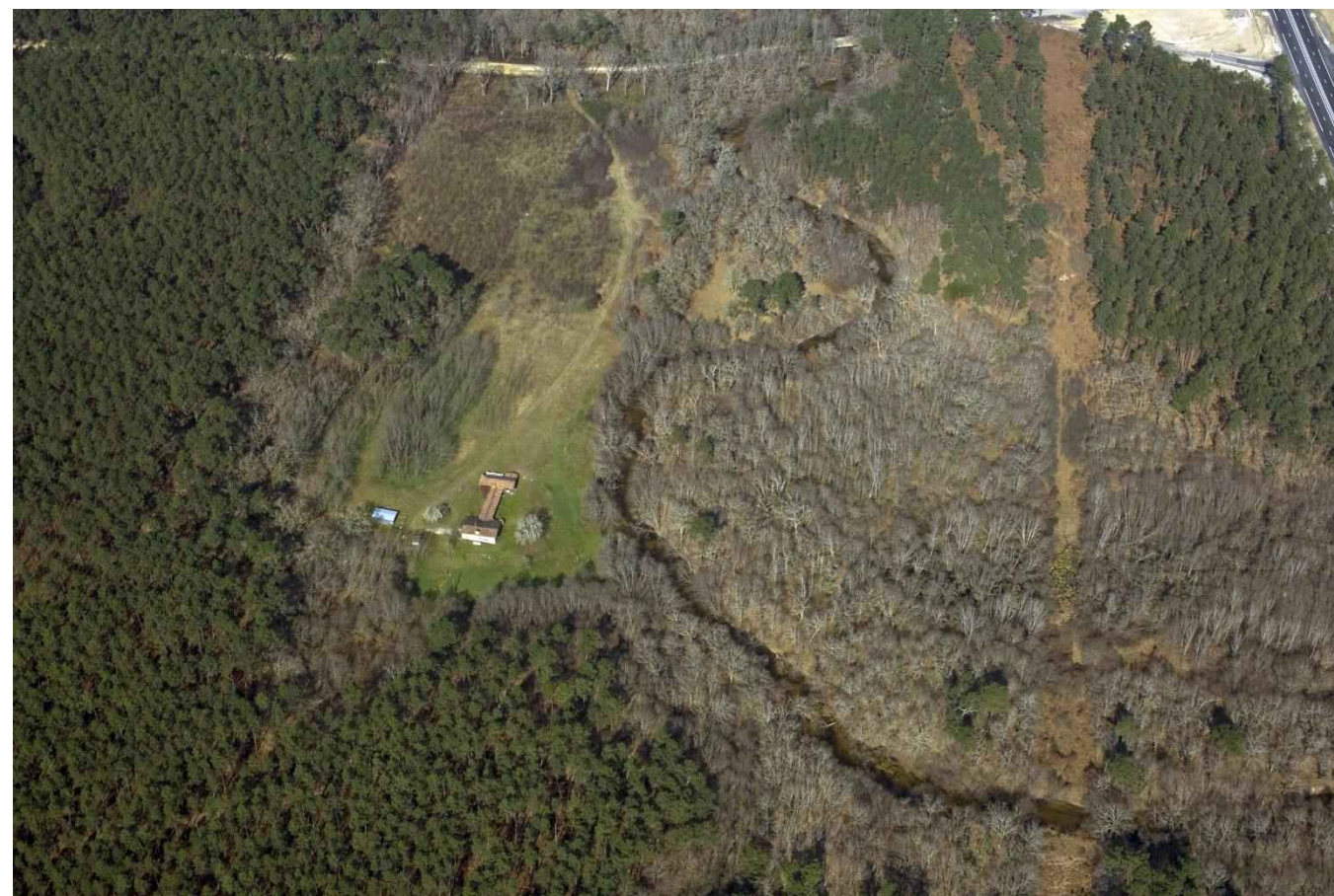
Figure 23: Le Ciron au niveau de la commune de Bernos-Beaulac (Source : SNCF RÉSEAU, 2010)
