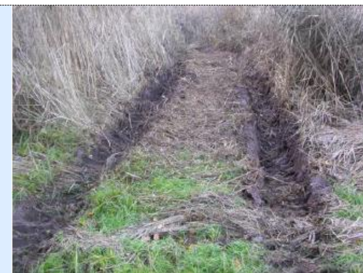
Figure 1 : Ornières trop importantes justifiant le report des travaux – Renaturation de zones humides, CSA
