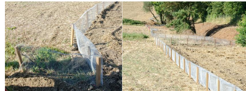
Retour en « U » à une extrémité et clôture à amphibiens
