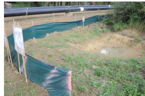
Coude de retournement en limite d'emprise du chantier
