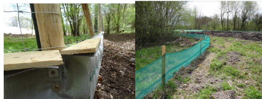
Exemple de fixation de bavolet et barrières anti-intrusion posées
