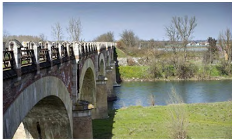
Figure 50: La Garonne à Saint-Porquier (Source : SNCF RÉSEAU - Paul Robin)
