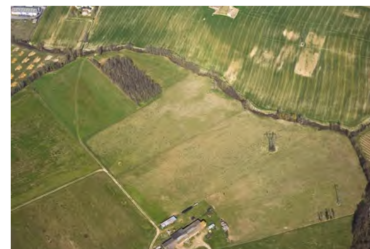
Figure 84: Le ruisseau du Vergnet souligné par sa ripisylve en limite de commune entre Bressols et Labastide-Saint-Pierre (Source : SNCF Réseau)
