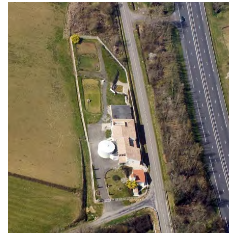
Figure 49: L'usine de traitement des eaux de Candes à Saint-Michel (Source : SNCF Réseau, 2012)
