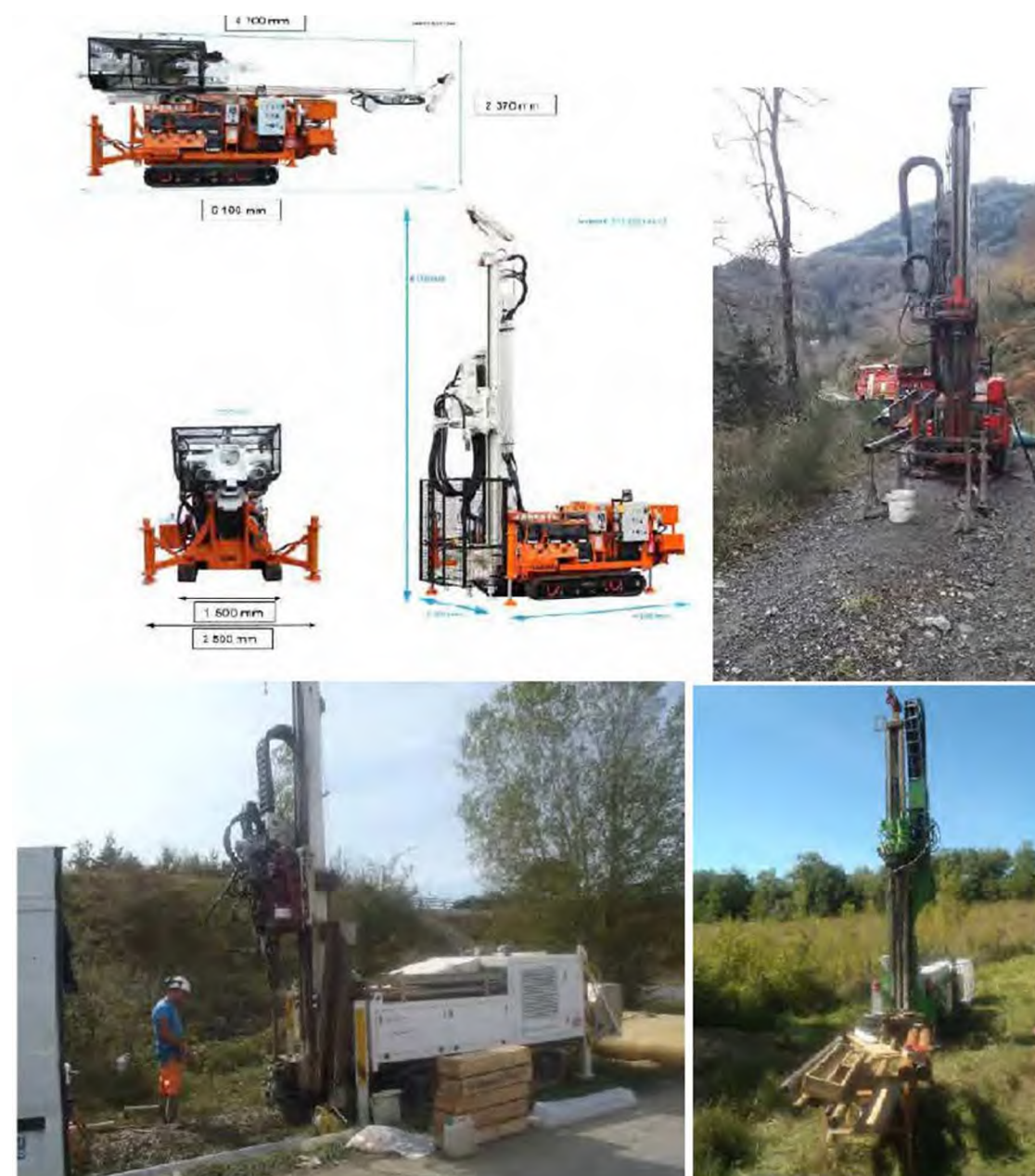
Figure 2 - Exemple de machines utilisées dans le cas de sondage carotte, à la tarière, ou pressiométrique (Source : SNCF Réseau, 2024)
