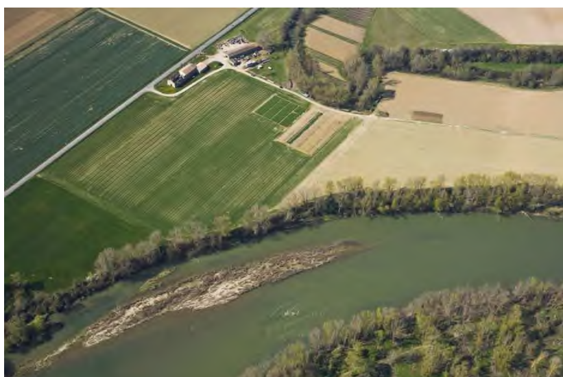
Figure 58: La Garonne au niveau du méandre de Samponne (Source : SNCF Réseau, 2012)
