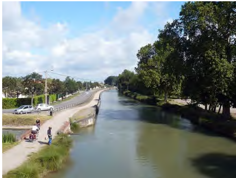
Figure 140: Le canal latéral à la Garonne à Saint-Jory (Source : Egis)
