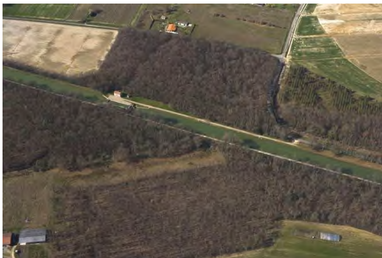
Figure 78: Le canal de Montech à Lacourt-Saint-Pierre, corridor de la sous-trame aquatique et axe de déplacement de la grande faune (Source : SNCF Réseau, 2012)
