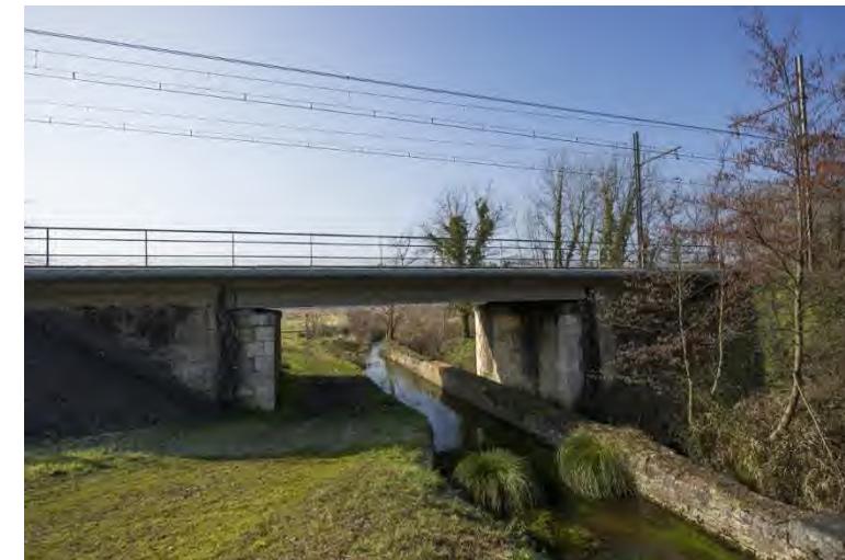
Figure 79 : L'Estey Mort, commune de Saint-Médard-d'Eyrans (Source : SNCF Réseau - Paul Robin)
