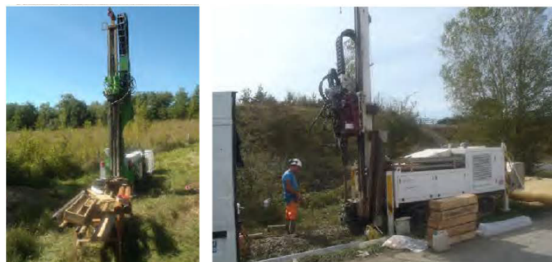
Figure 3: Exemple de sondages géotechniques (Source : SNCF Réseau)
