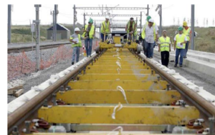
Figure 5 : La mise en place des voies (Source : SNCF Réseau)
