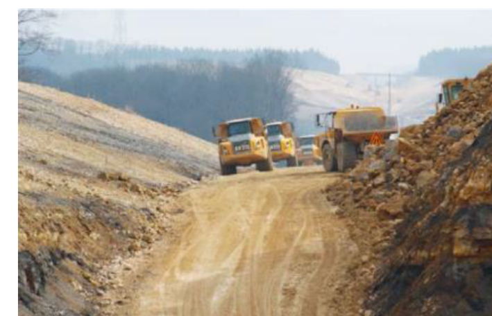
Figure 4 : Travaux de génie civil : terrassements (Source : SNCF Réseau)
