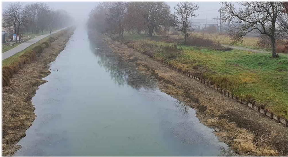
Exemple de risberge favorable à l'installation de fascines visible en période de chômage (source : SNCF)
