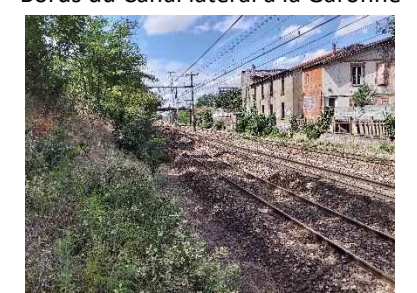
Abords de voie ferrée
