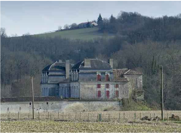
Figure 97: Château de Trenqueléon sur la commune de Feugarolles (Source : SNCF RÉSEAU - Paul Robin)
