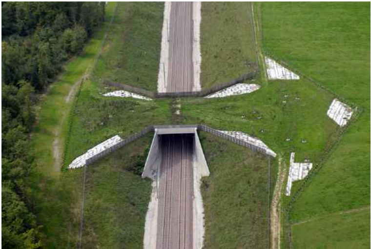
Figure 85: Exemple de passage grande faune
