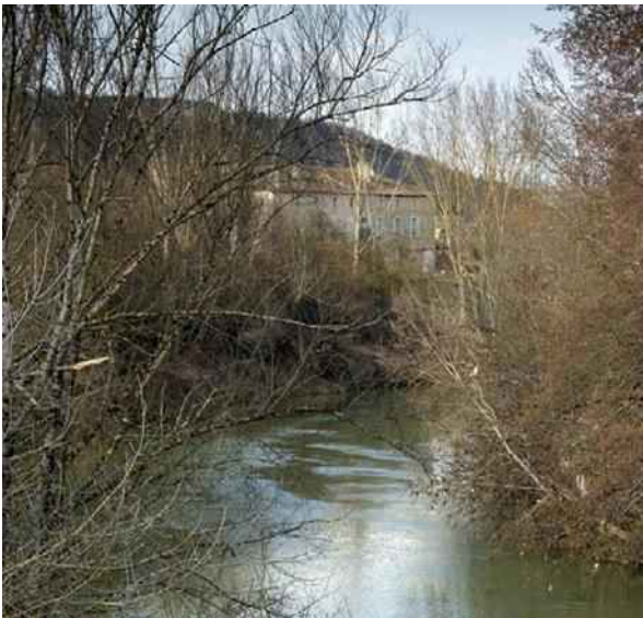
Figure 26: La Baïse à Vianne (Source : SNCF RÉSEAU - Paul Robin)
